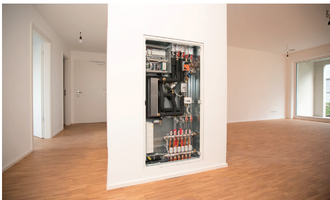
Heizt und kühlt - diese Wohnungsstation von PEWO wurde speziell für das Bauvorhaben in Frankfurt am Main entwickelt.
